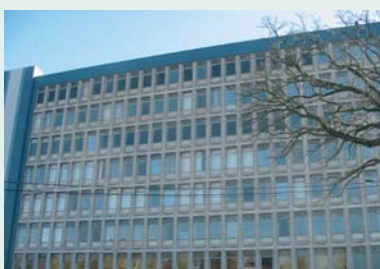
Couillet. Transformation potentielle de bureaux en résidentiel / Couillet. Potential transformation of offices into housing
